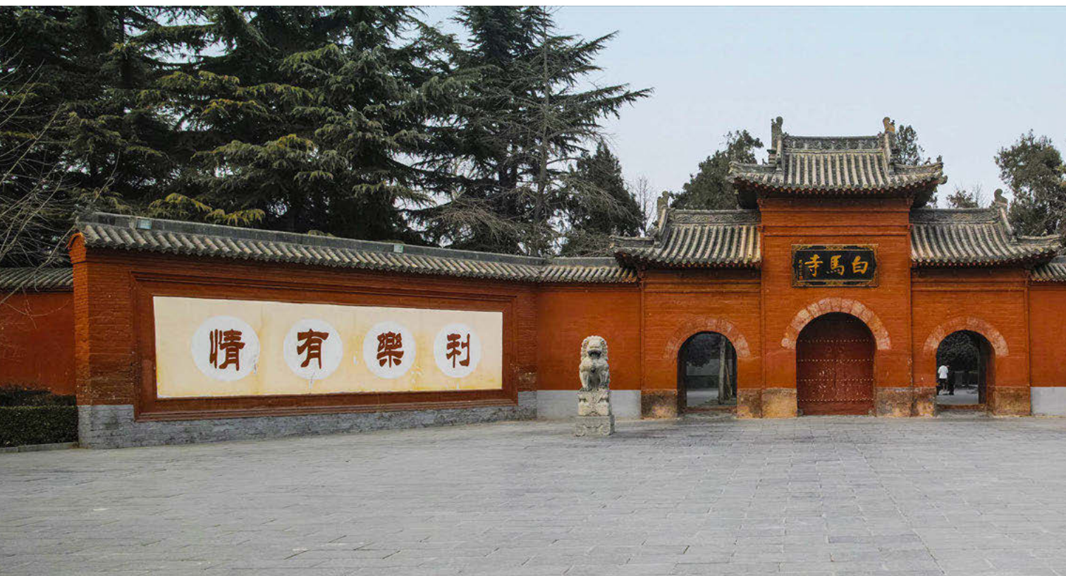
白马寺入口全景 Panorámica de la entrada al complejo
